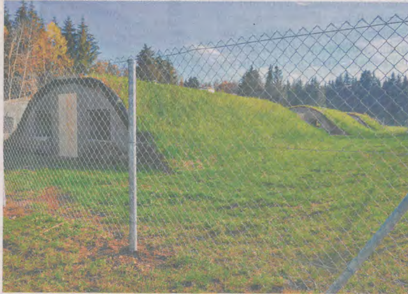
Erst vor wenigen Tagen wurden die Instandsetzungsmaßnahmen zum Erhalt der ehemaligen KZ-Tonröhrenbaracken abgeschlossen.
